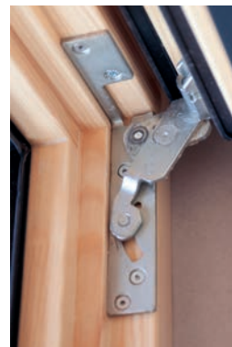
Technik befindet sich im Fensterfalz
